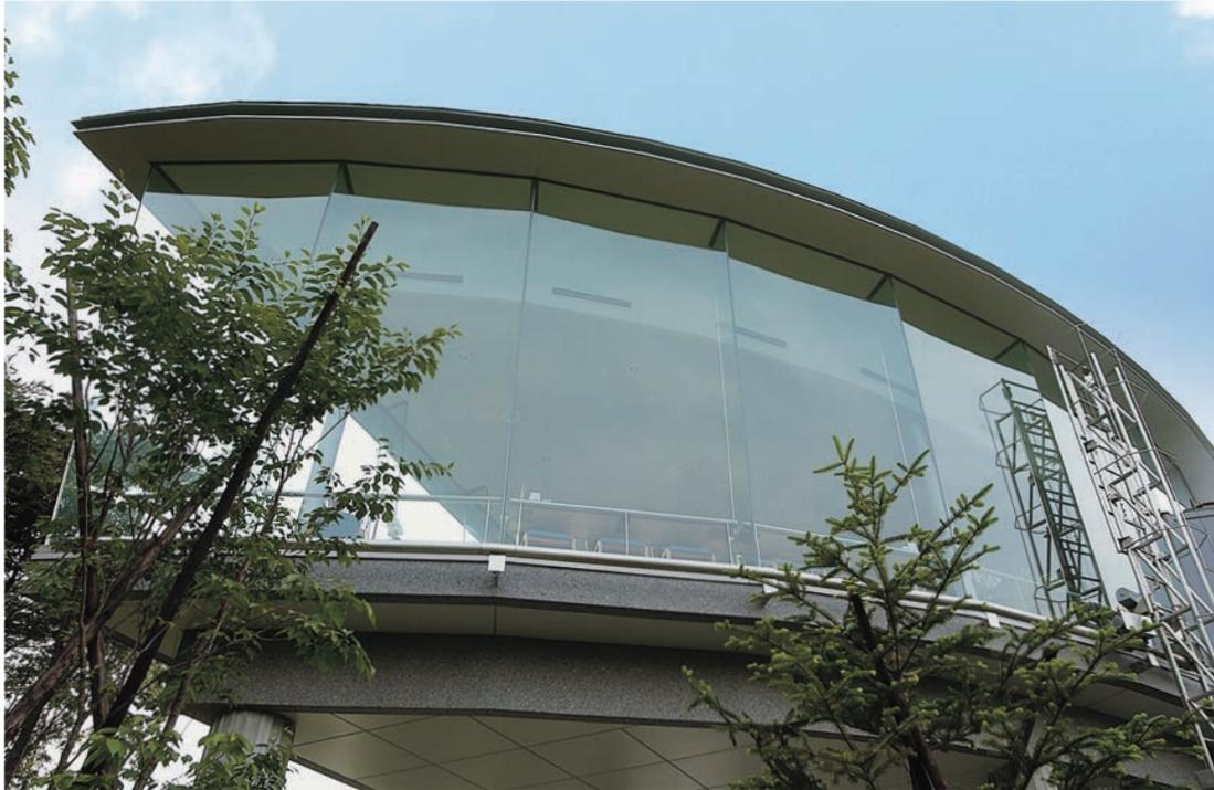
▲周りのアルミサッシに色合わせした焼付塗装仕上。一見ガラスしか見えない程スリムなガラススクリーン枠
