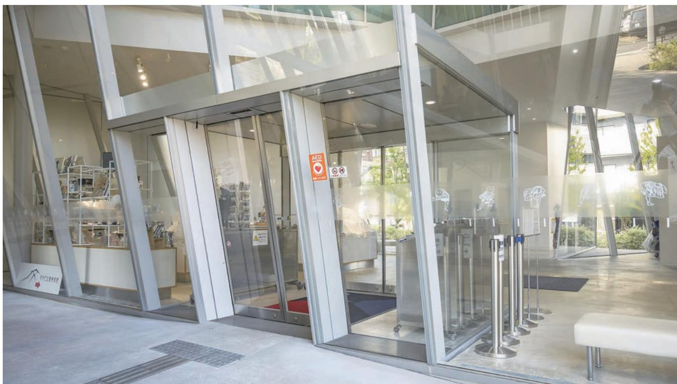
▲建物のスリットに合わせて斜めに設置された自動ドア
