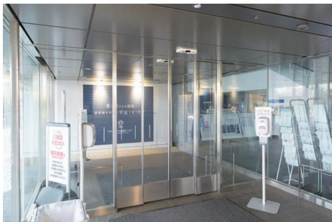
▲風除室内部の自動ドアにはムダ開きを削減する「e-セービングドア」を採用
