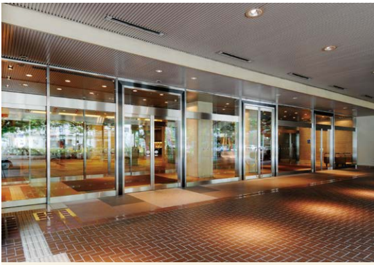
エントランスの手動ドアを自動ドアにリニューアル 開口部がわかりやすいデザインになっています
